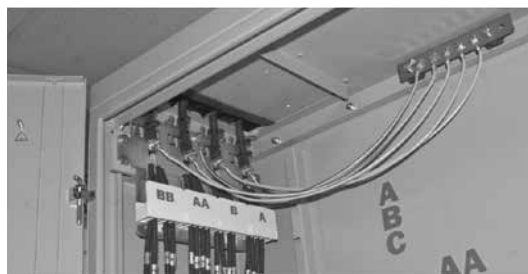
Заземление кабелей
